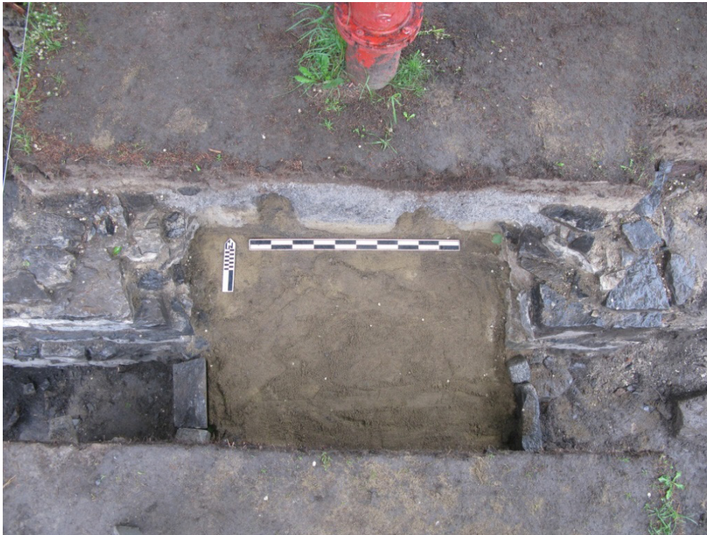
Figure 17. Destruction du vestige 77A100 pour l'installation d'une borne-fontaine. (Source : Université Laval, 2015 (100-0248))
