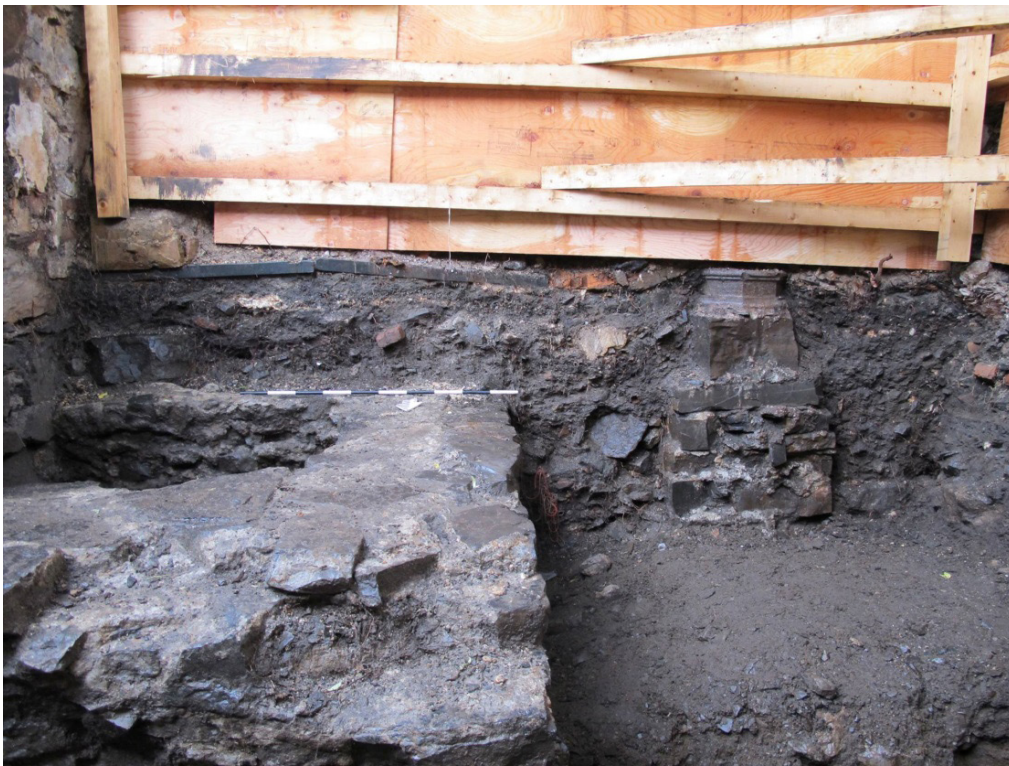
Figure 14. Les deux dalles d'ardoises vue en paroi (en dessous des étaçonnements), provenant des sous-opérations 73C et 73D. (Source : Laurence Pouliot, 2014)
