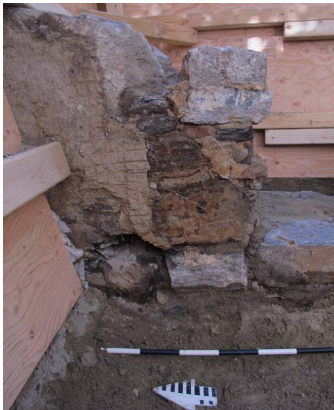
Figure 48. Crépi, parement ouest, section nord, 73C100h (Source : Université Laval, 2014)
